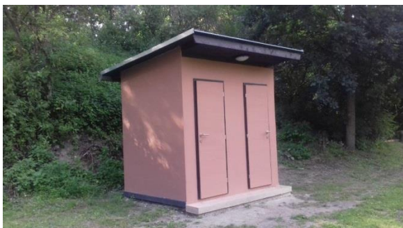
▲► Obr. Nové WC v areálu střelnice
